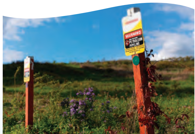
Jalon signalant la présence d'un pipeline. Source : Avec l'autorisation de la CEPA
