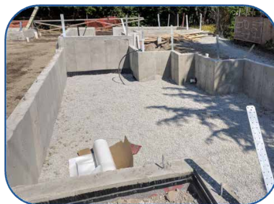
Figure 8 Couche continue de gravier concassé clair servant de base pour le drainage des dalles et le contrôle des gaz du sol.
