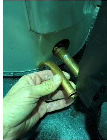
Figure 81 : Tube de dispersion modernisé fabriqué à partir de tube de cuivre de ½ po
