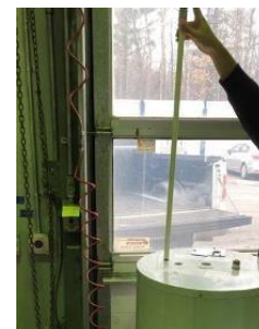
Figure 78 : Retrait du tube plongeur du réservoir
