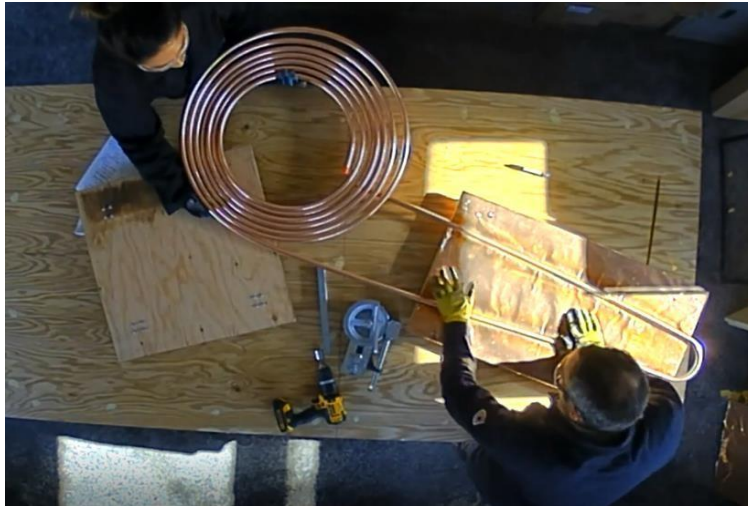
Figure 15 : Vérification du rayon de courbure à l'aide du gabarit de l'absorbeur
